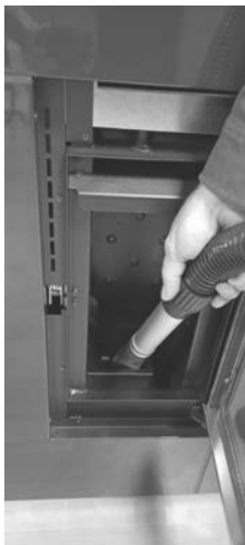
Fig. 36 - Rengöring av brännkoppfacket
