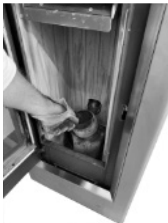
Fig. 34 - Borttagning av brännkoppn
