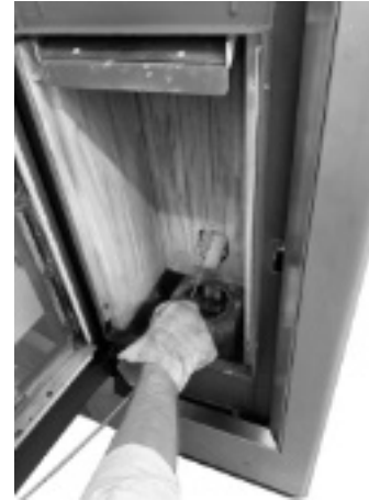
Fig. 37 - Rengöring med piprensare
