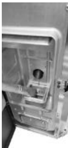
Fig. 36 - Rengöring av brännkoppfacket
