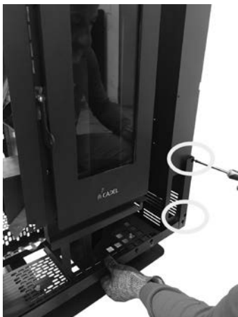
Fig. 33 - Fästning av det nedre fästet
