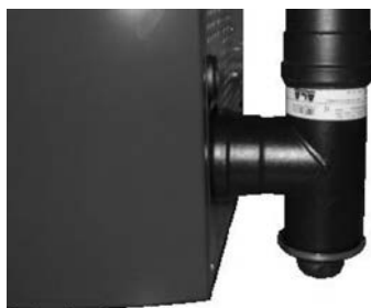
Fig. 63 - Rengöring av röckanal
