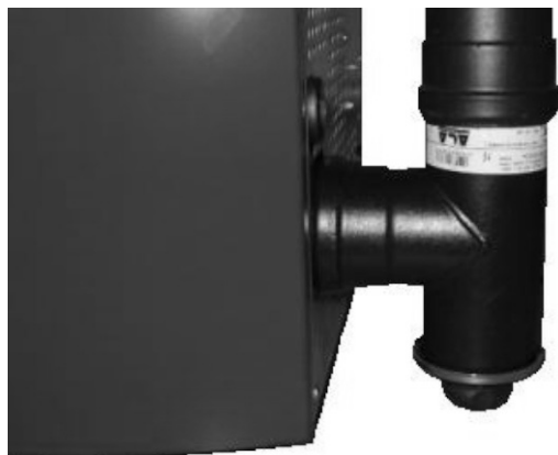
Fig. 22 - Rengöring av rökkanal
