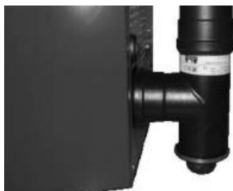
Fig. 34 - Rengöring av rökkanal
