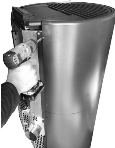
Fig. 21 - Borttagning av de bakre skruvarna
