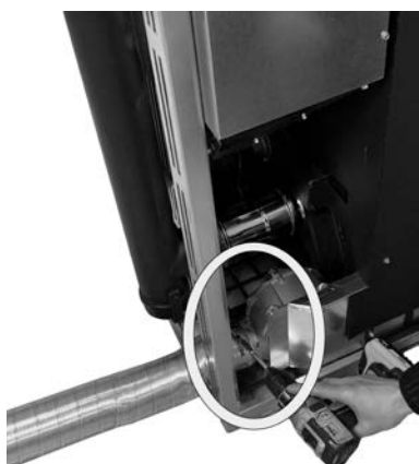
Fig. 60 - Blockera slang
