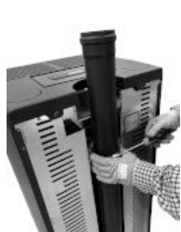
Fig. 48 - Bakre rökgasutlopp monterat
