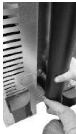
Fig. 50 - Koppla in rör d.80 mm
