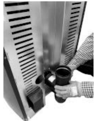
Fig. 45 - Anslut T-kopplingen
