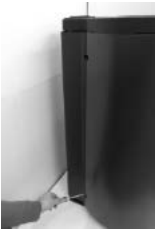
Fig. 65 - Skruva loss skruvarna på sidorna
