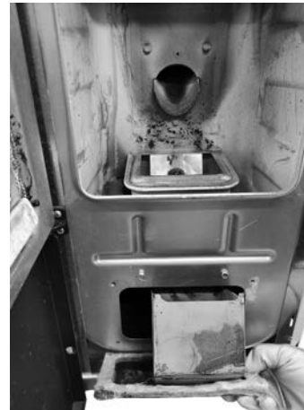
Fig. 69 - Ta bort inspektionslocket
