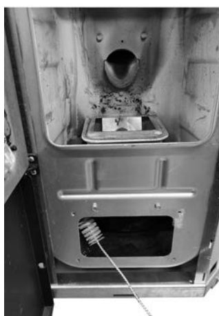
Fig. 74 - Rengör med en rörrengöringsborste
