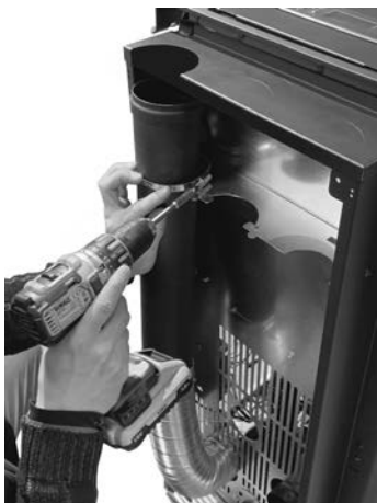
Fig. 63 - Blockera rör d.80 mm
