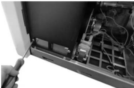
Fig. 78 - Rengöring av rumsfläkt
