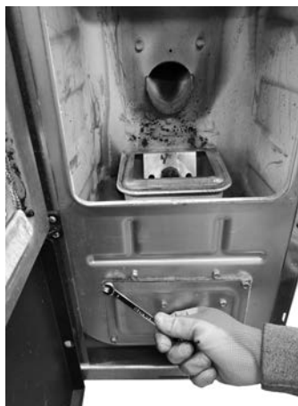
Fig. 72 - Ta bort skruvarna
