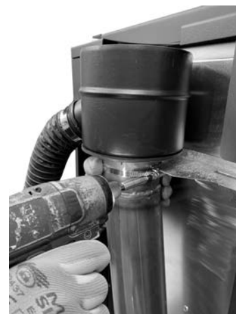
Fig. 48 - Blockera med klämma
