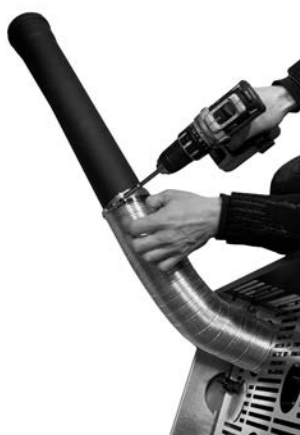
Fig. 61 - Anslut rör d.80 mm
